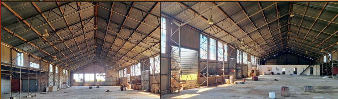
Die staalkonstruksie kommersiële gebou is ±1200m 2 en bestaan uit 3 erwe
